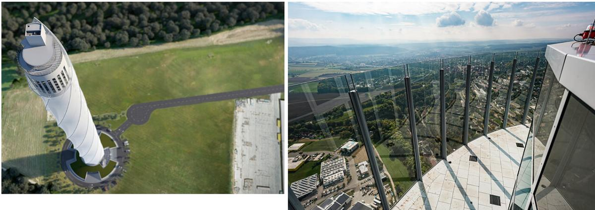
Mit 12 Schächten und Fahrgeschwindigkeiten von bis zu 18 m/s bietet der Turm nie dagewesene Möglichkeiten zur Lösung kommender Herausforderungen. 3 Schächte sind für den revolutionären seillosen MULTI Aufzug vorgesehen.
